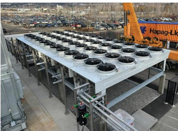
Während der Sommermonate wird die Wärmepumpe transkritisch betrieben und dient als zusätzliche Kühlquelle, während hocheffiziente Rückkühler als primäre Kältequelle erhalten bleiben.
