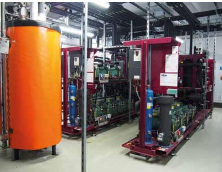
Die Regelung der Anlage erfolgt über das Wurm Regelsystem FRIGOLINK. Für einen intelligenten und effizienten Betrieb kam das speziell für CO<sub>2</sub> entwickelte Hauptmodul HCO<sub>2</sub> von Wurm zum Einsatz. Hier trug TEKO einen maßgeblichen Part zur Entwicklung bei.
