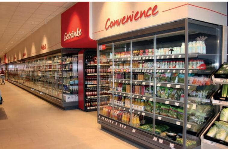
Die Kühlregale sind mit Glastüren versehen, die Kälteanlage wird transkritisch mit R 744 betrieben. Zur Einsparung der Heizungsanlage wird die gesamte Abwärme zu Heizzwecken genutzt. Eine zusätzliche Wärmepumpen- und Klimafunktion ist im Kälteverbund installiert. Die Geothermie wurde in den Kühl- und Heizprozess integriert.
