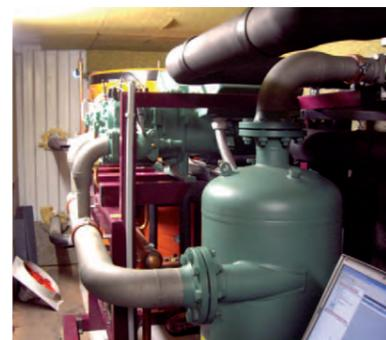
Zur Erzeugung des benötigten Normalkühlbedarfs ist ein Schraubenverbund mit zwei Verdichtern der TEKOPACK-Serie 7000 (Typ: TPN2 – HKS8571-140-ECO) mit einer Kälteleistung von 398 kW bei den genannten Bedingungen installiert. Die mittels Schieber stufenlos regelbaren Schraubenverdichter sind mit einem Vi-Ausgleich (variable Druckauslassöffnung) versehen. Dies sorgt für einen optimierten Betrieb der Verdichter in den unterschiedlichen Lastzuständen.
