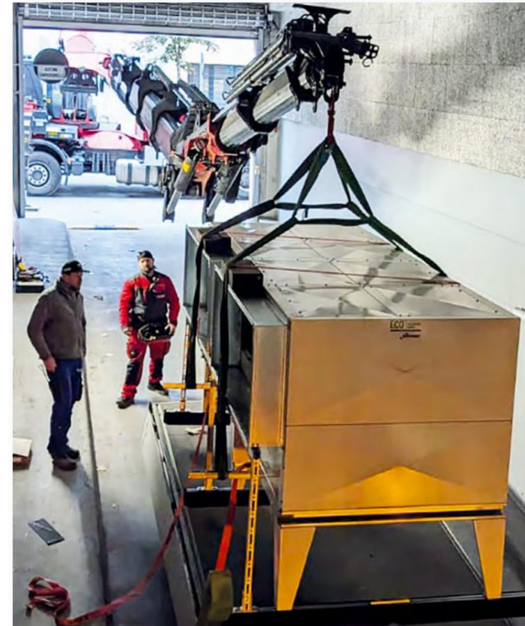
Der Gaskühler wurde mit einem Ladekran nahezu horizontal eingebracht. Copyrightrechte liegen bei KOCH – Kälteanlagenbau GmbH
