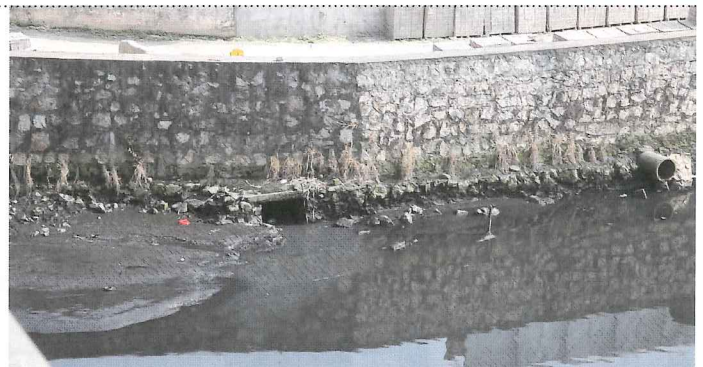
In China wird zur Entsorgung von Abwässern oft das natürliche Fluss- und Grundwassernetz genutzt.
